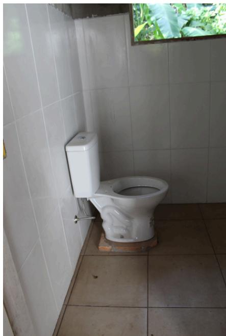
Fotografia colorida de um banheiro revestido com piso de cerâmica bege e azulejos brancos. À esquerda, destaca-se um vaso sanitário oval com base branca, elevado por um sóculo de tijolos vermelhos sem acabamento.
