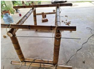
Perfure cada perna nas laterais do bambu com uma broca, atravessando-o de ponta a ponta, garantindo que a barra roscada de 3/8 passe pelo interior do bambu para proporcionar sustentação.
