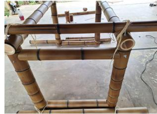
Após garantir que a barra atravessou a lateral da mesa de ponta a ponta, retire a barra, encaixe o bambu que fez a boca de peixe e, por fim, atravesse novamente a barra para sustentar a estrutura. Coloque arruela e porcas na ponta. Repita o processo na outra lateral.
