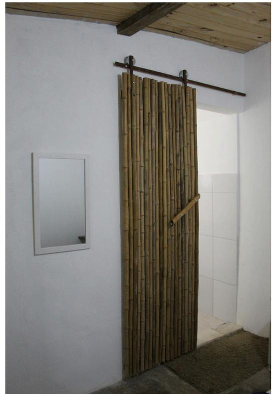
Fotografia colorida de uma ampla porta de correr construída de bambu. Instalada em um trilho de metal, fixado em uma parede branca, a porta, parcialmente aberta, revela um ambiente interno com paredes revestidas de azulejos de tons claros. À esquerda da porta, na parede branca, destaca-se um espelho retangular com moldura também branca.
