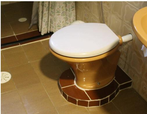
Fotografia colorida de um banheiro revestido com piso de cerâmica marrom claro e azulejos bege, decorados com desenhos florais. À direita, ao lado de uma pia, destaca-se um vaso sanitário oval com base marrom e tampa branca, elevado por um sóculo, base de alvenaria, revestido com lajotas em tons de marrom avermelhado. No chão, próximo ao vaso, encontra-se um ralo redondo branco. Ao fundo, uma cortina estampada com folhagem em verde e branco, parcialmente aberta, revela a área do chuveiro.
